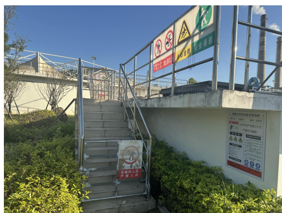
图 7 砂滤池底部入口处
