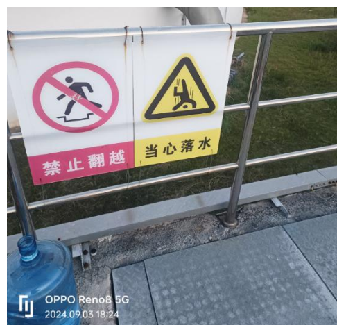
图 8 进水渠告知牌
