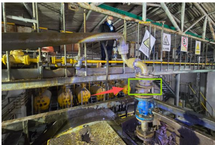
图 2 涉事拉断阀
