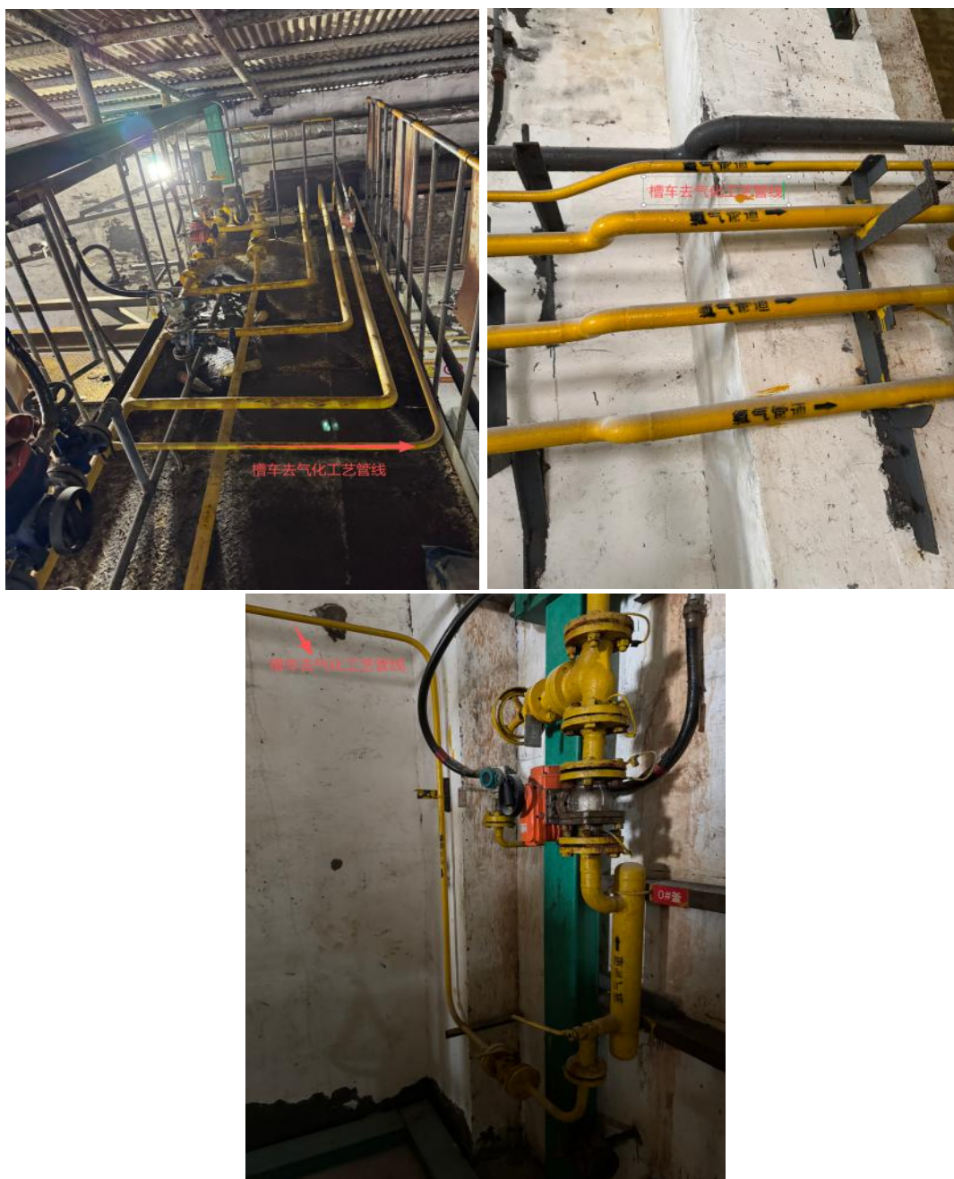
图 10 涉事槽车罐连接气化器
