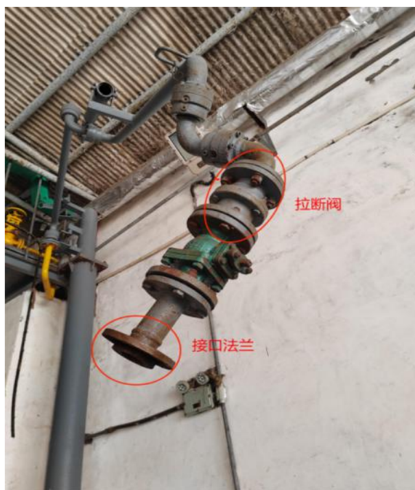
图3 改造后的鹤管
