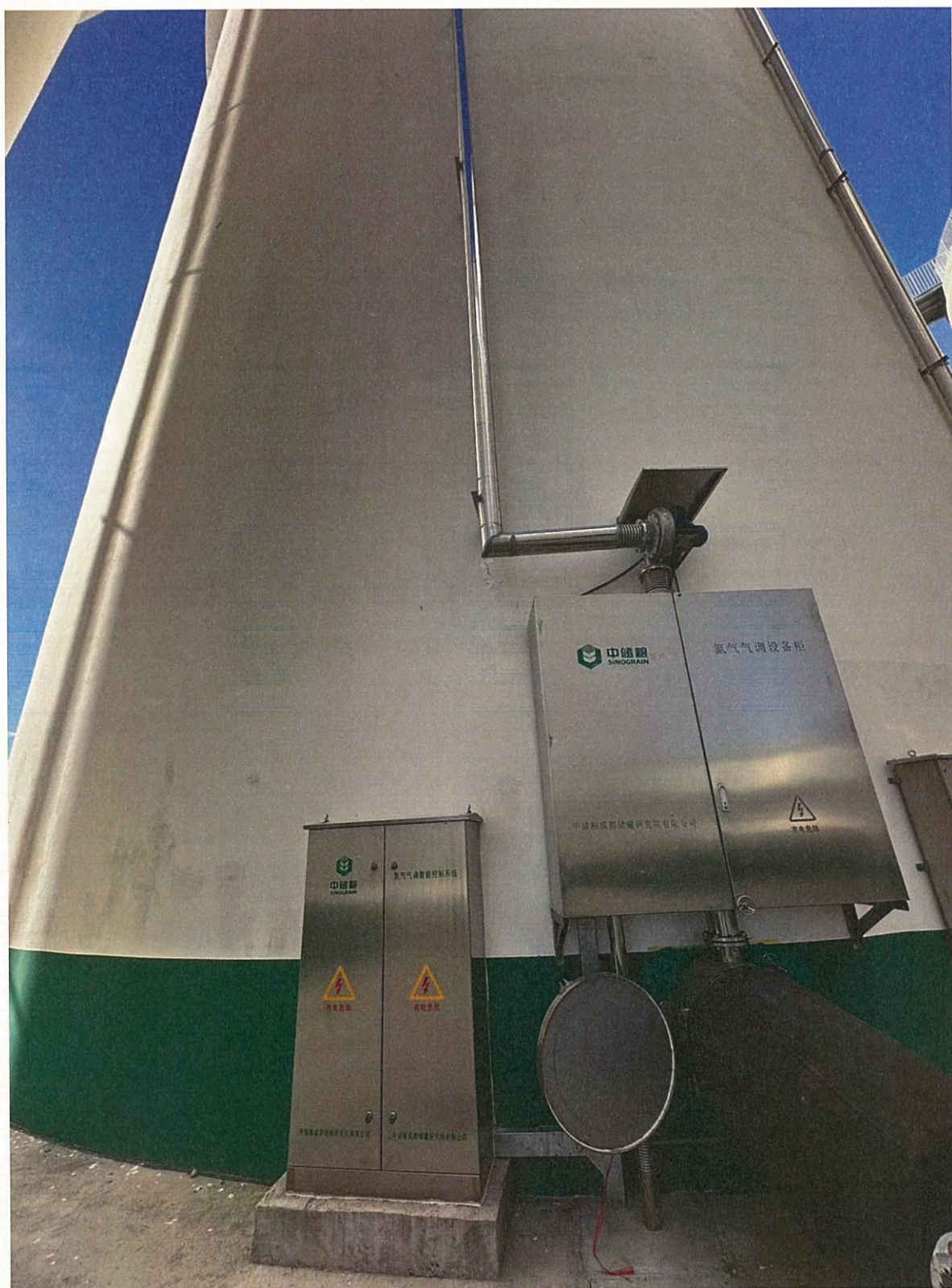
图14 充氮设备进气控制开关图
