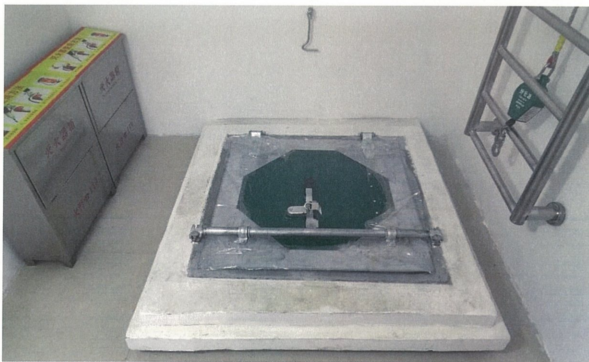
图8 50号粮仓检查间内门（检粮门）关闭状态图
