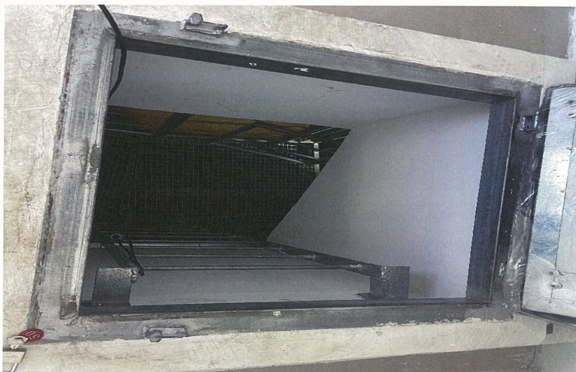
图9 50号粮仓检查间内门（检粮门）开启状态图
