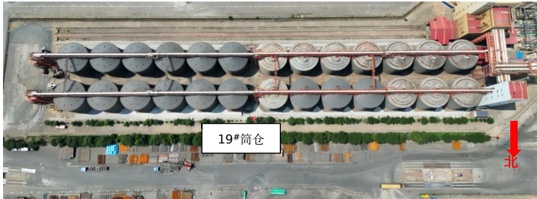
图 1 筒仓区域俯视图
