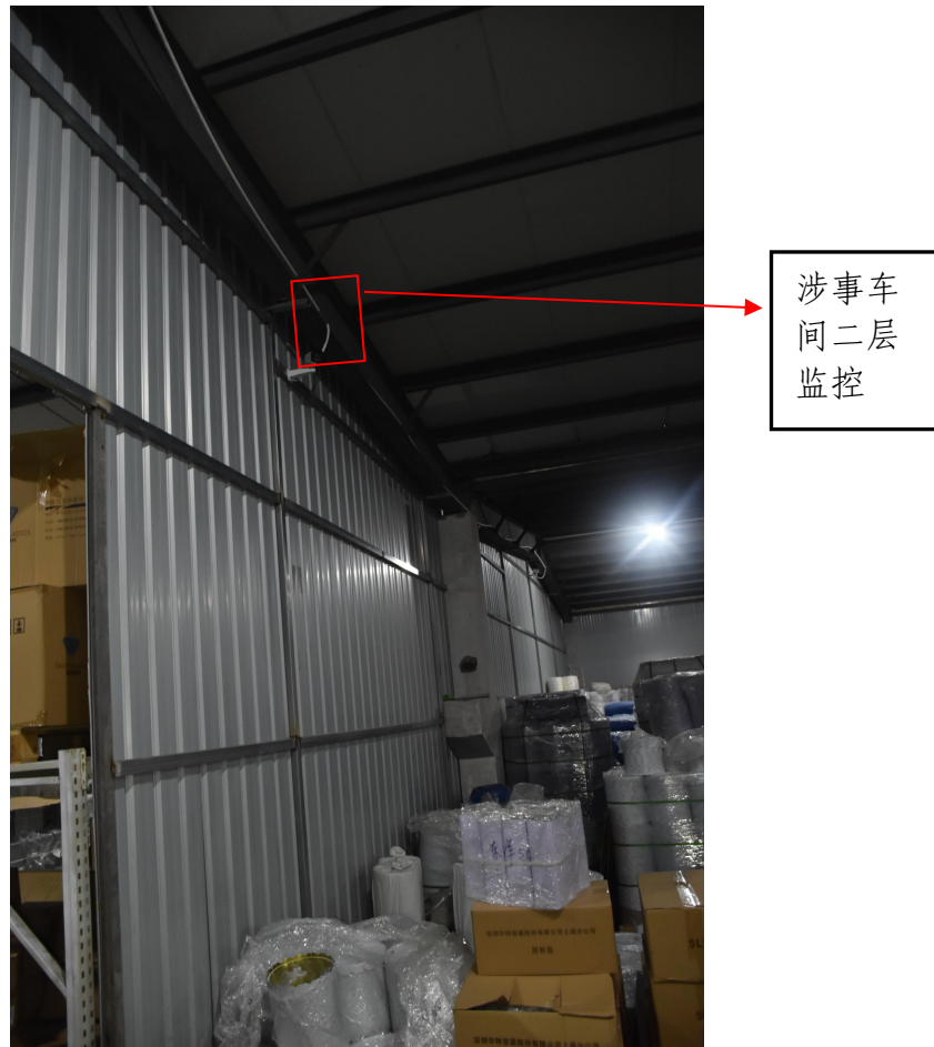
图 14-15 事故现场监控
