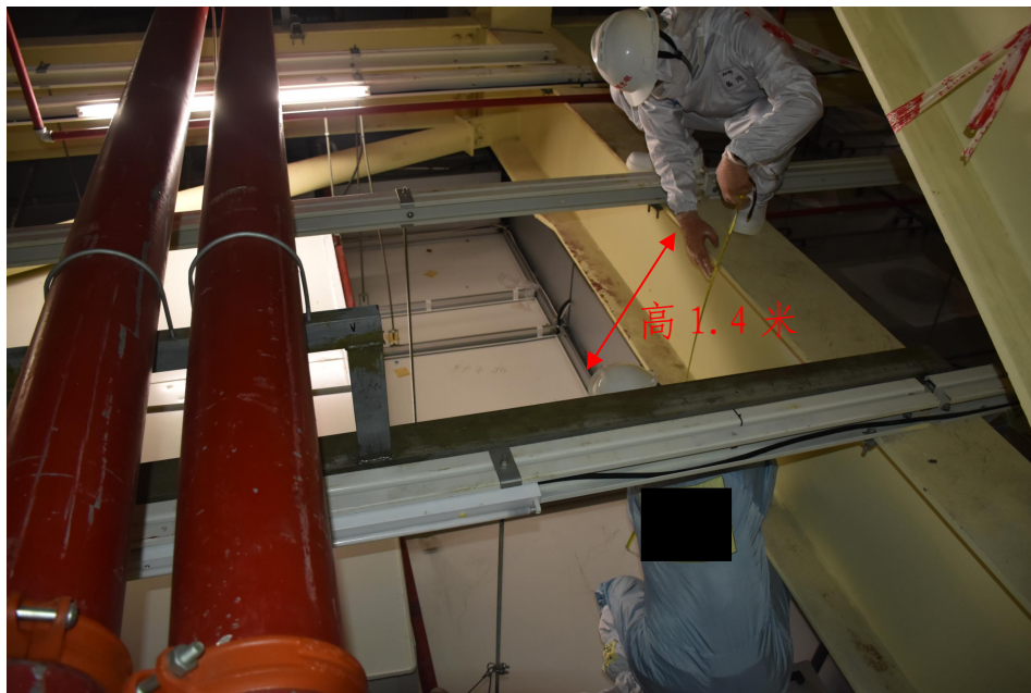
图8 横梁钢结构与吊顶板距离
