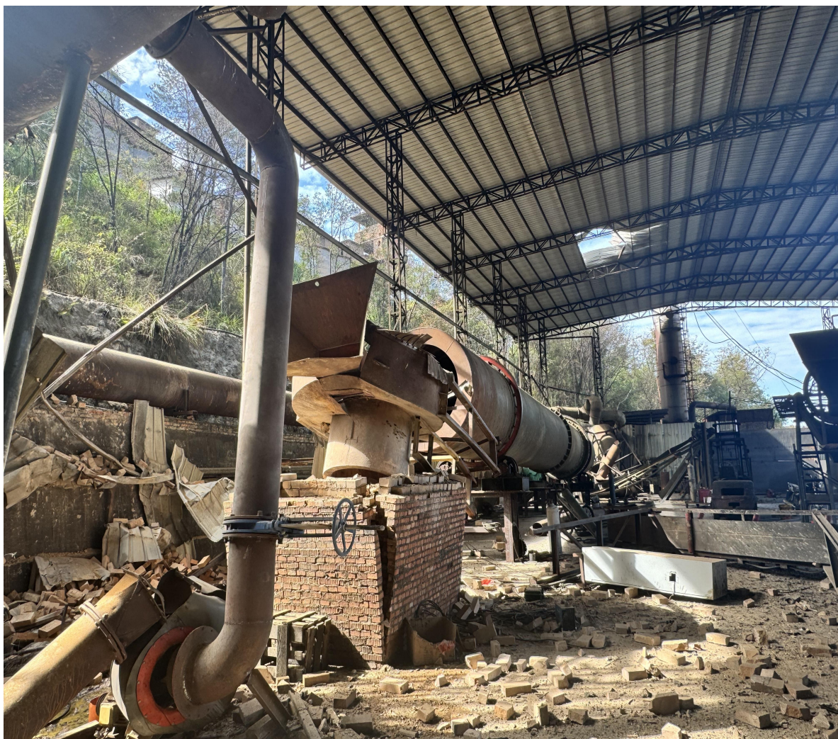
图 5：事故后烘干炉进料端现场
