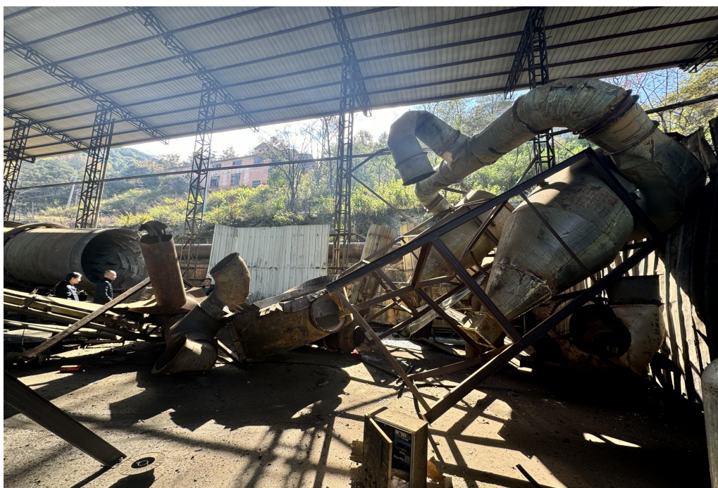
图6: 事故后烘干炉出料端现场
