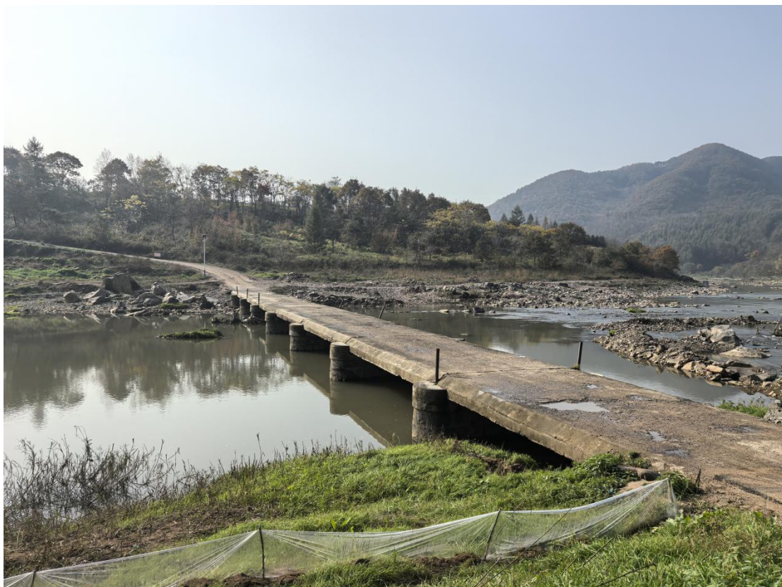
图一 双十二号桥整体外观
