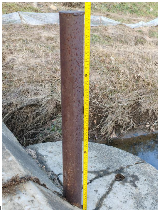
图二 桥面部分警示桩情况
