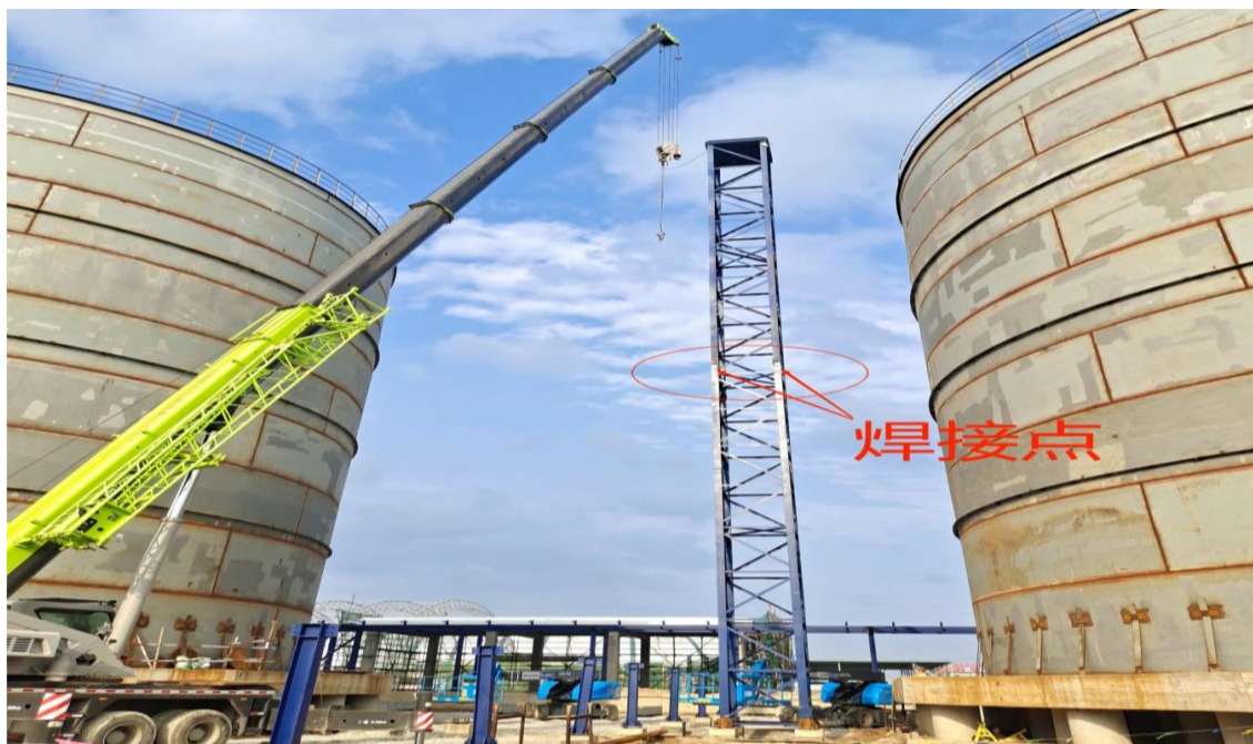
图2 钢柱侧面总体外观
