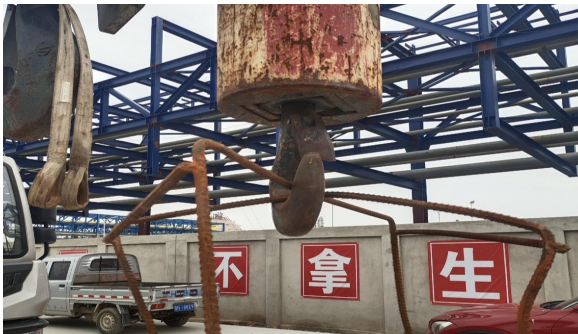
图6 吊笼的挂法（事后还原拍摄）
