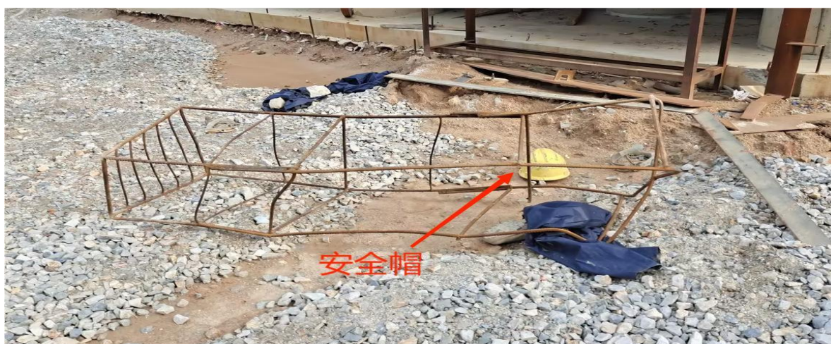
图5 施工用的吊笼
