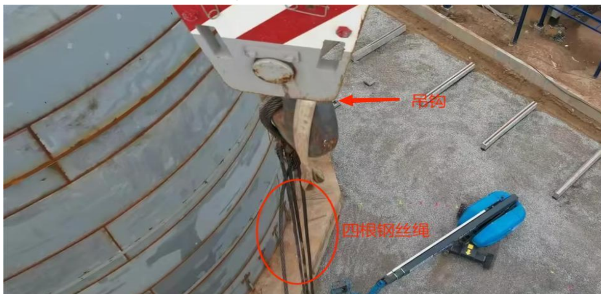
图3 吊钩上用于吊装上部钢柱的钢丝绳
