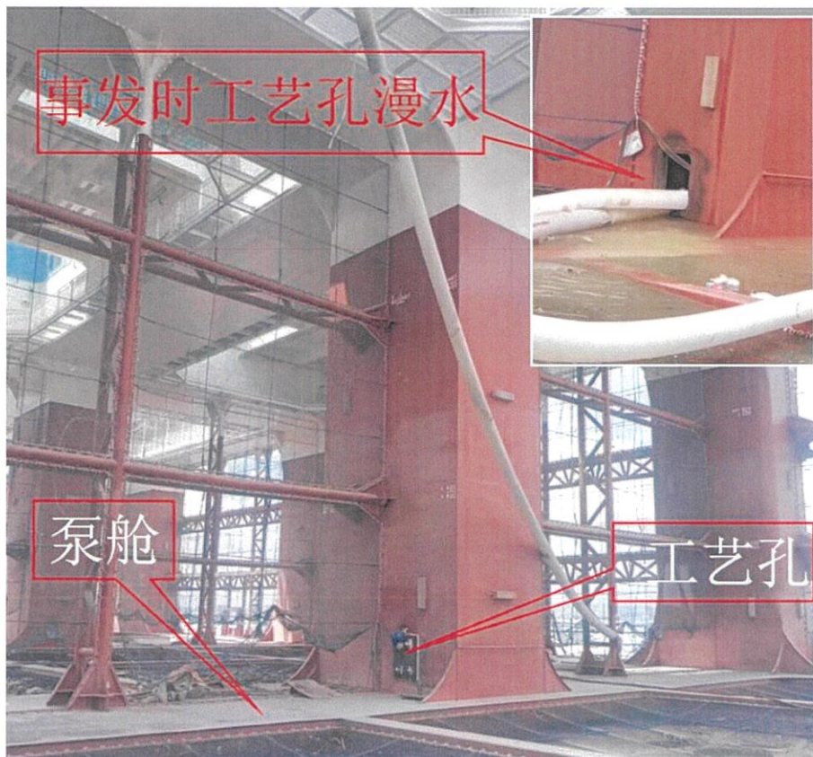
图3 “普盛海洋牧场6号”主甲板及泵舱情况
