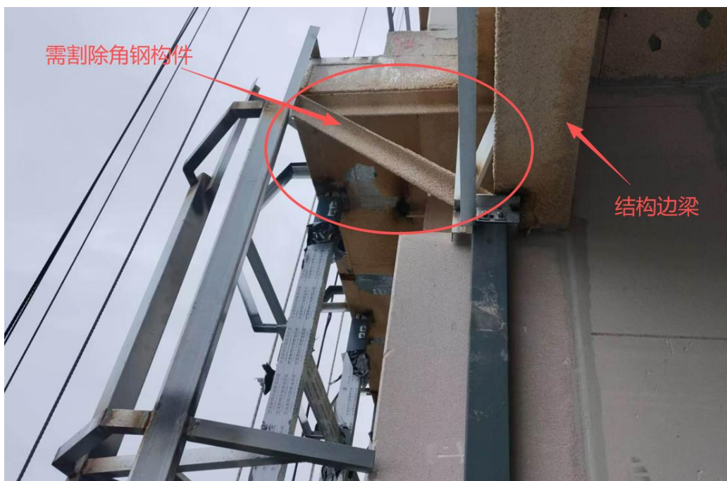
图6 角钢构件割除前类似实物图
