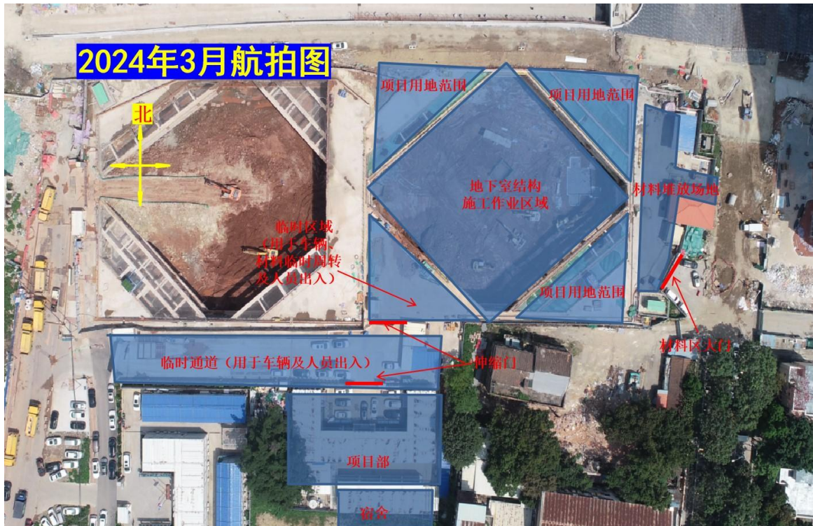
图2 项目工地航拍图（最近为2024年3月航拍）
