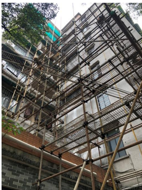
图 5 脚手架搭了五层，一至五层安装了钢芭
