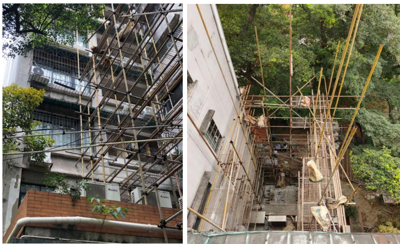
图 6、7 脚手架因为场地南侧有一层书吧，所以架体分了台阶
