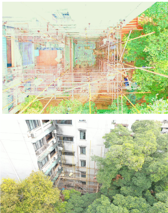
图 3、4 施工现场俯视“回”字型概貌
