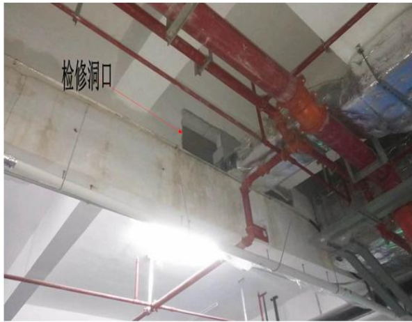
图 7 检修洞现场图
