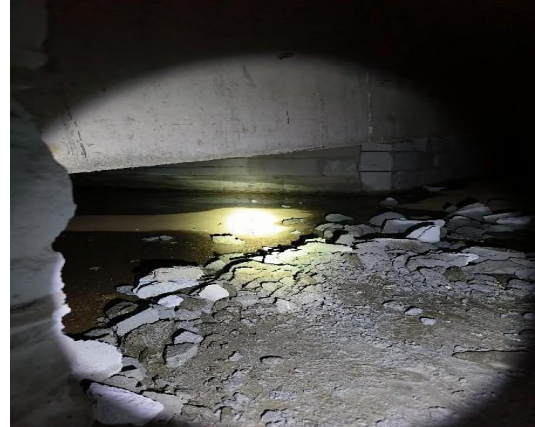
图 10 涉事检修洞内部情况
