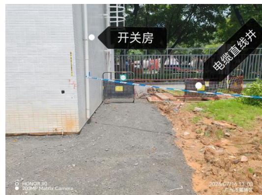
图 6 施工敷设电缆的终点位置
