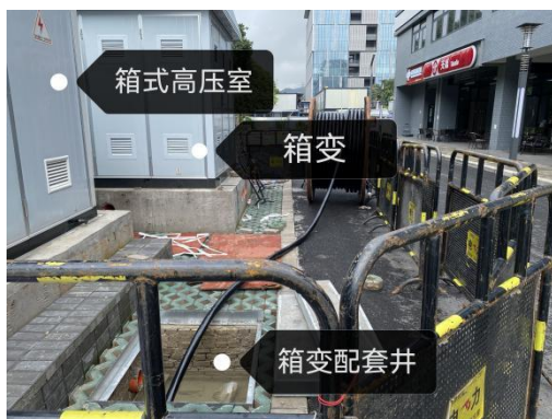
图 5 施工敷设电缆的起点位置
