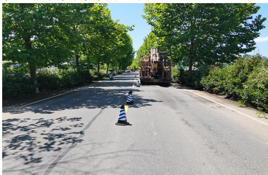
图 2 事发路段道路照片
