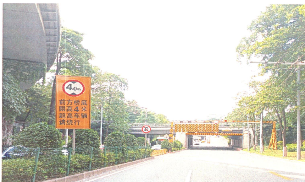
图 6：事发路段限高标志牌照片（前方桥底限高 4 米超高车辆请绕行）
