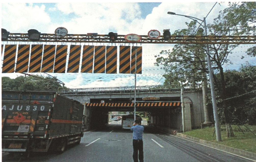
图 7: 事故现场第一个限高架照片(设有限高 4.0m 标志, 实测高度 4.18m)
