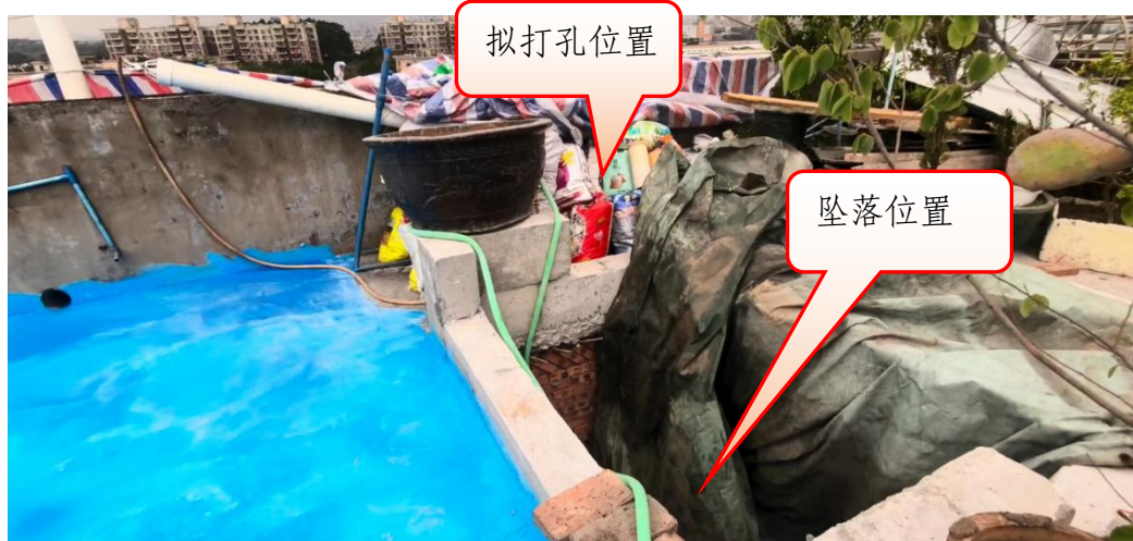
图 3：涉事电梯井口及北侧拟打孔位置
