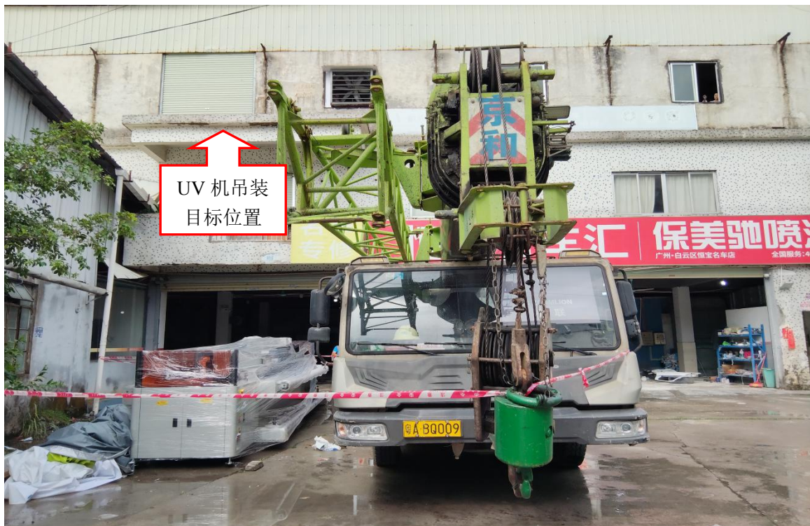
图 2 事故发生现场（因救援有部分移动）
