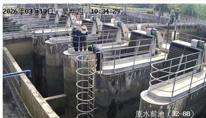
图7 现场监控记录事发经过情况
