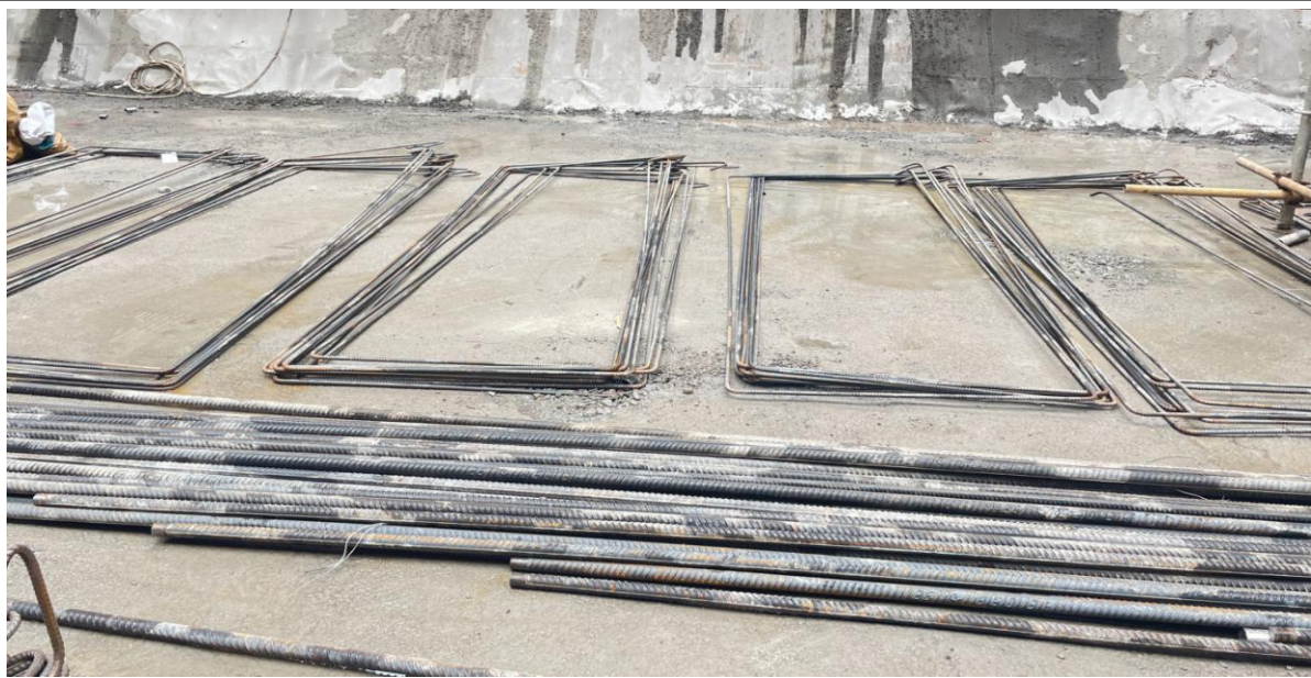
图 4 现场堆放的底板横梁主筋和箍筋
