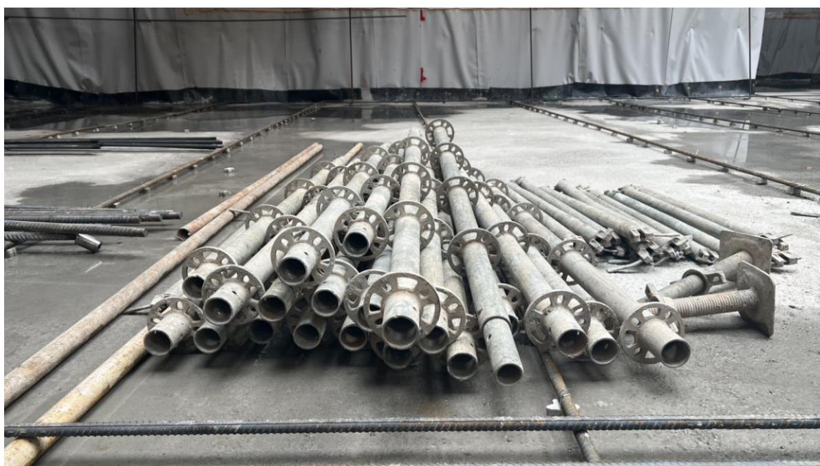
图 3 现场堆放的盘扣架钢管和配件
