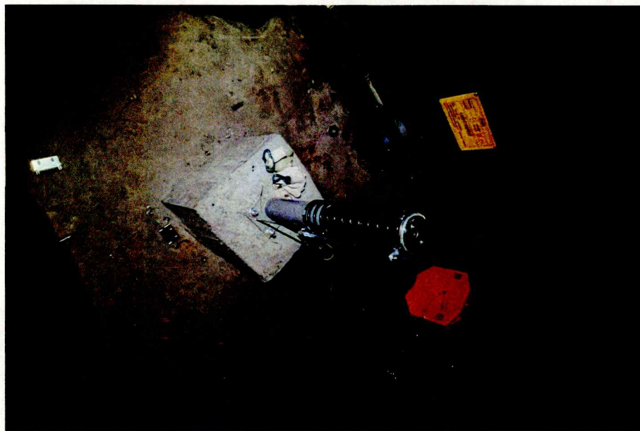
图 5 底坑缓冲器
