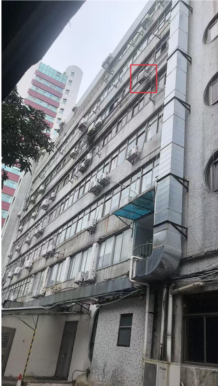
图 2 建设大厦北侧外景，6 楼红色方框里的涉事空调外机，距地面高度约 15 米。
