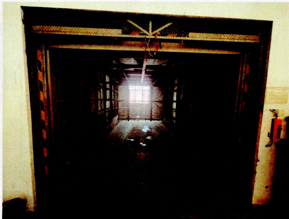
图 3 升降平台作业台情况（2 楼）
