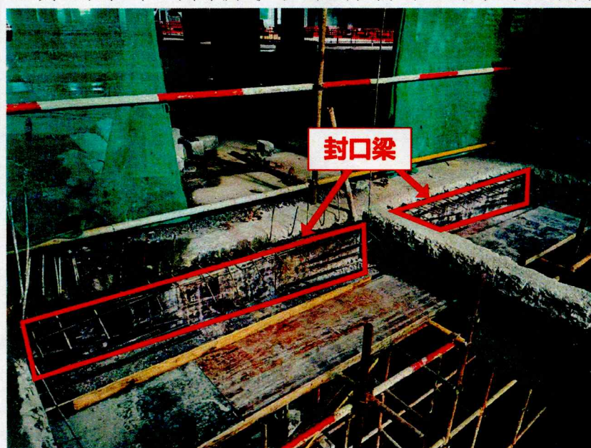
图3 封口梁浇筑施工情况
