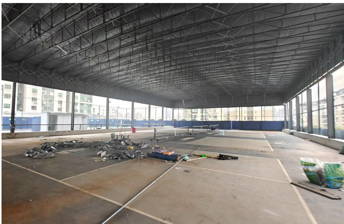
图 2 电动雨蓬的内部构造
