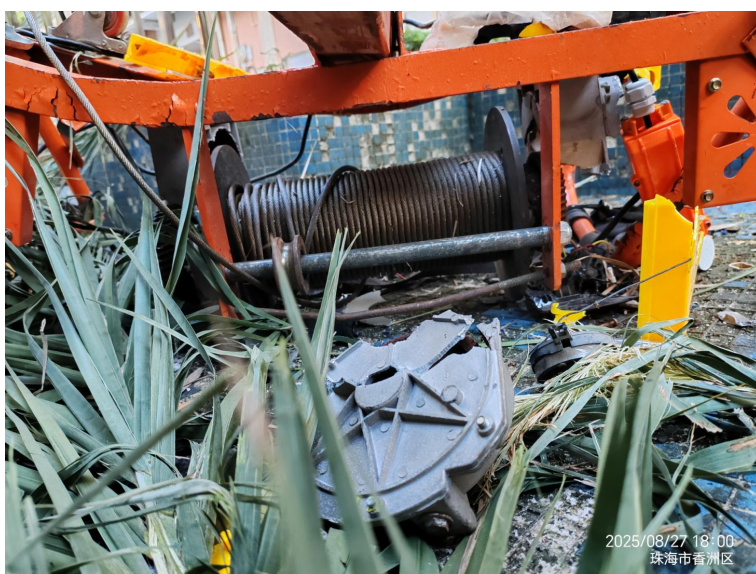
图 6 地面有个橙色的吊具，吊具下面有钢丝绳卷筒。
