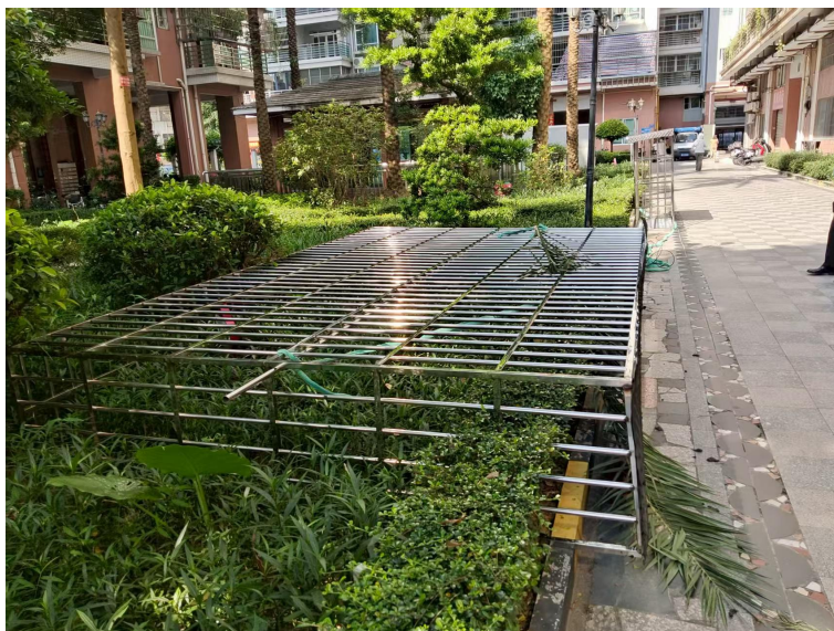
图 3 地面有等待安装的防盗网，防盗网上有绿色的布绳。
