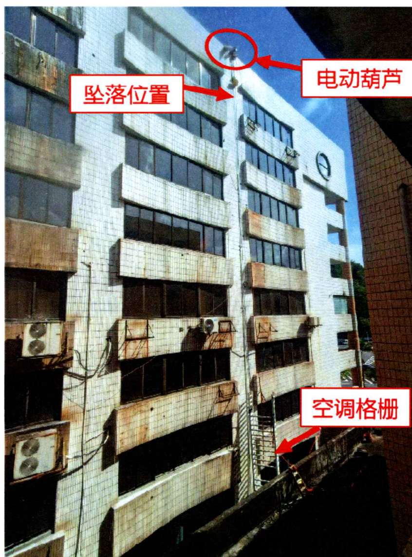
图 1 亚仿集团大厦北侧外墙
