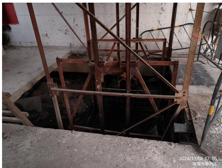
图 6 物料提升机的北侧，显示东北角有个木梯，木梯通往物料提升机下方。
