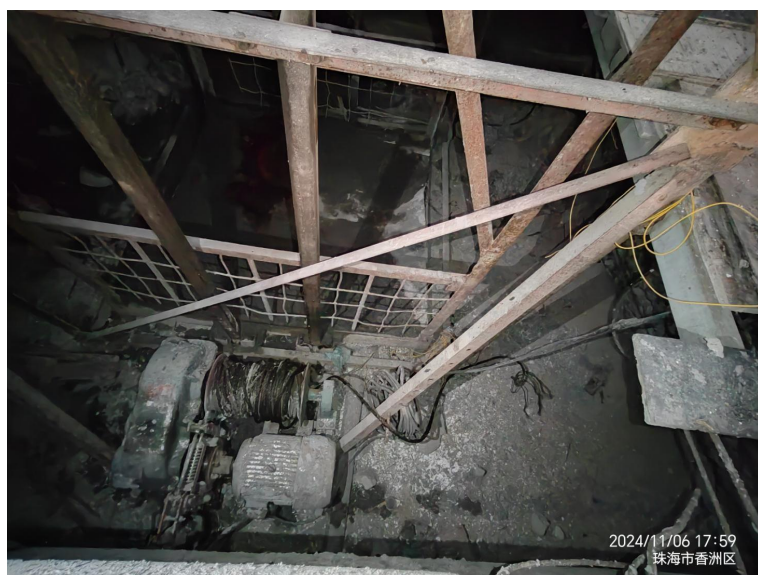
图 7 物料提升机的上方，钢井架结构搭建至 5 层，长宽约 2.1 \times 2.1 米。
