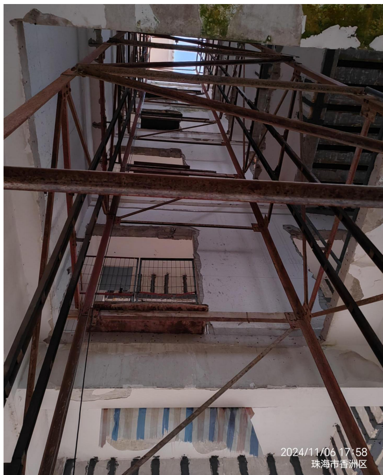
图 7 物料提升机的上方，钢井架结构搭建至 5 层，长宽约 2.1 \times 2.1 米。
