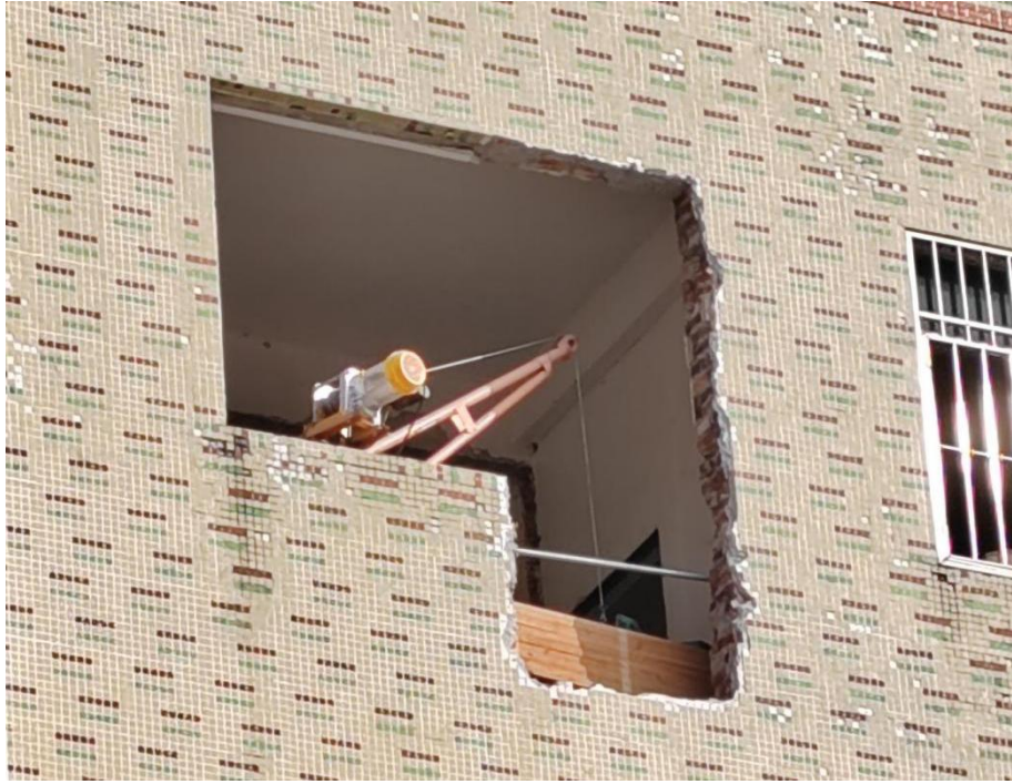
图 2 5 楼窗户内有吊机，用于吊建筑垃圾和建材。
