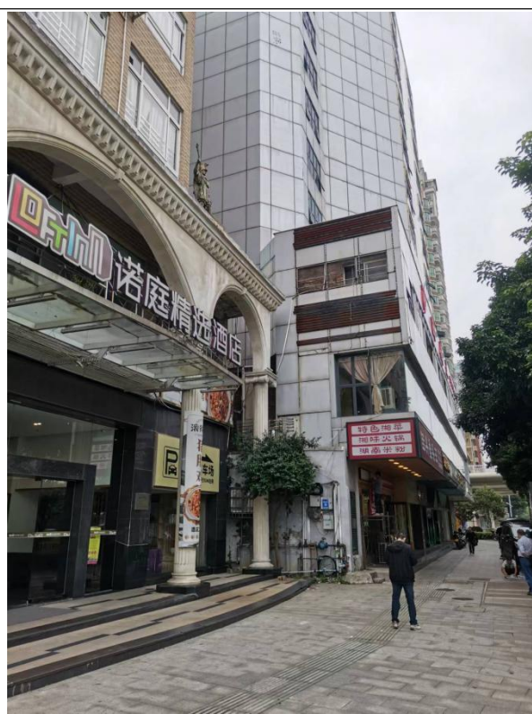
脚手架、广告牌拆除现场图片
