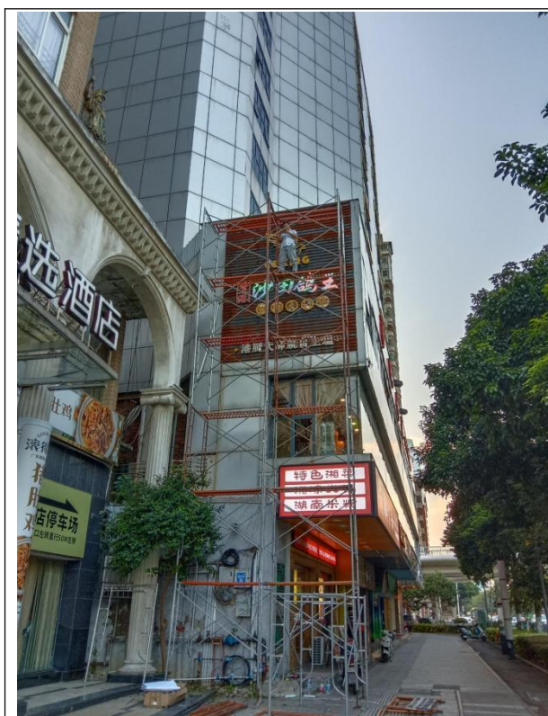
广告牌安装现场图片
