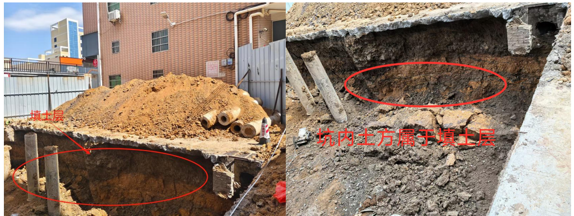
图2：坑内土方属于填土层
