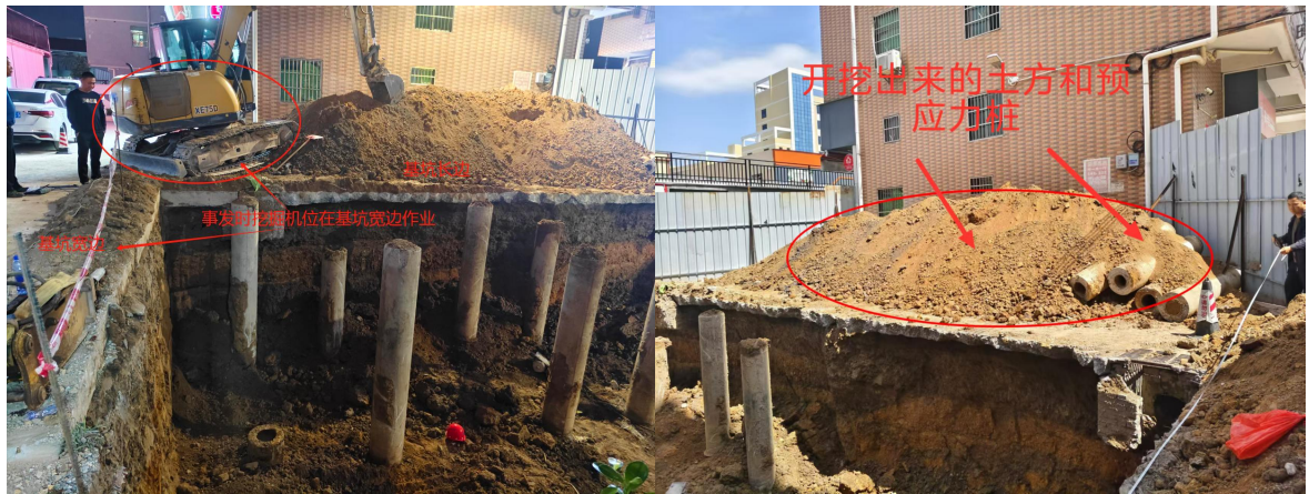
图2：坑内土方属于填土层
