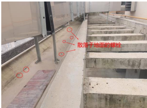
图 4 散落于地面的螺栓
