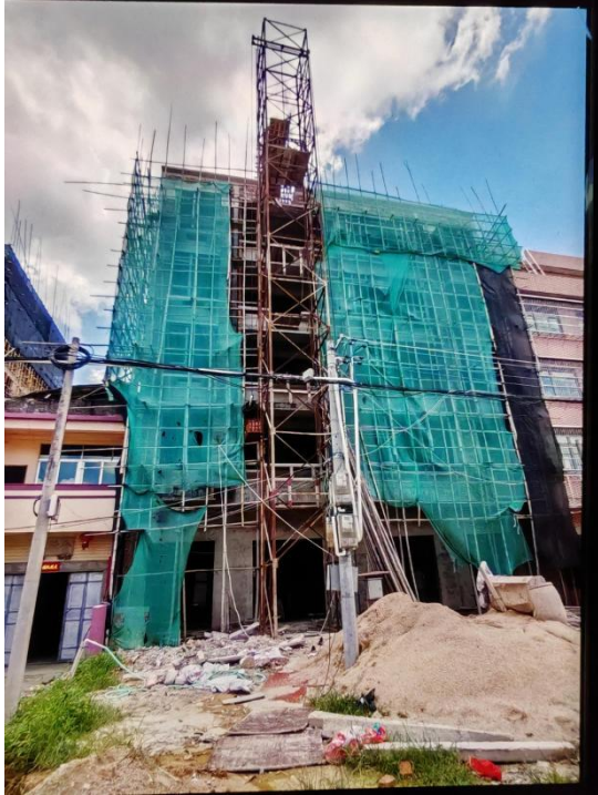
图 1 事故现场照片
