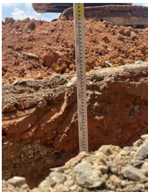
图3 开挖深度约3.5米
