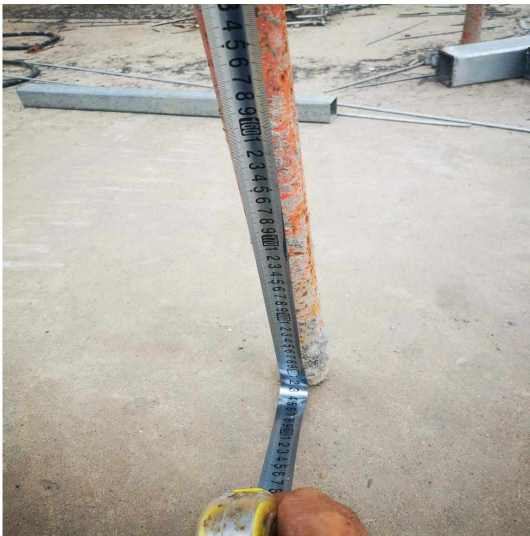
图 4 单层脚手架高度约 1.9 米
