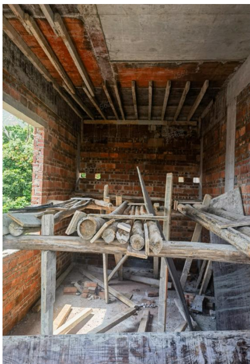
图 2：拆模的操作平台
