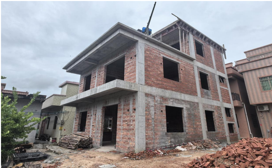
图 1：事故房屋全貌（东南面）
