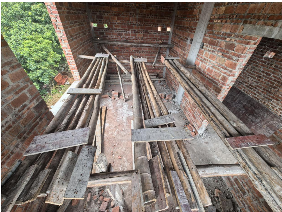
图 2：拆模的操作平台
