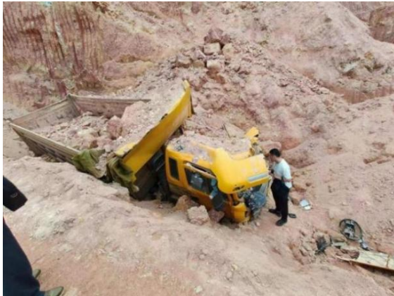
图6 事故现场照片（镜头向北）
