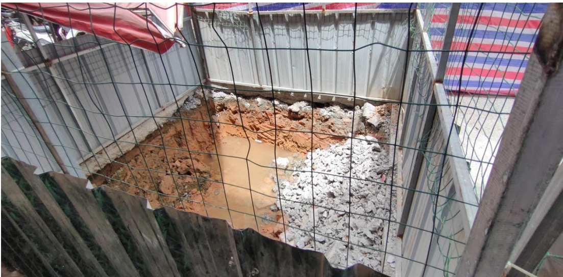
图 12 事故现场旁边围蔽的工作井
