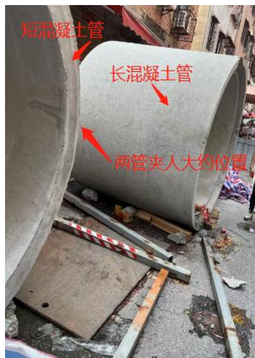
图14 事故发生后长短混凝土管 现场图
