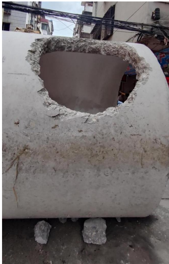
图 10 事故现场长混凝土管已打好直径 1.1 米的排水管孔
