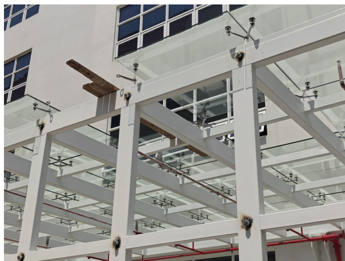
图 8 事故现场照片 图 9 未安装玻璃的顶棚缺口照片
