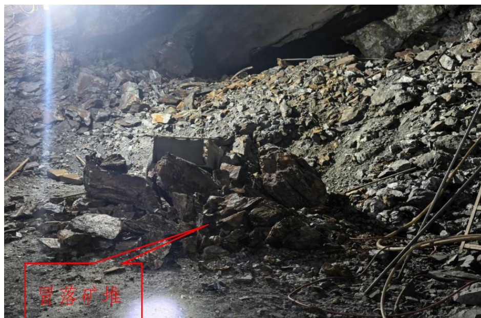
图 2（事故现场冒落矿石）
