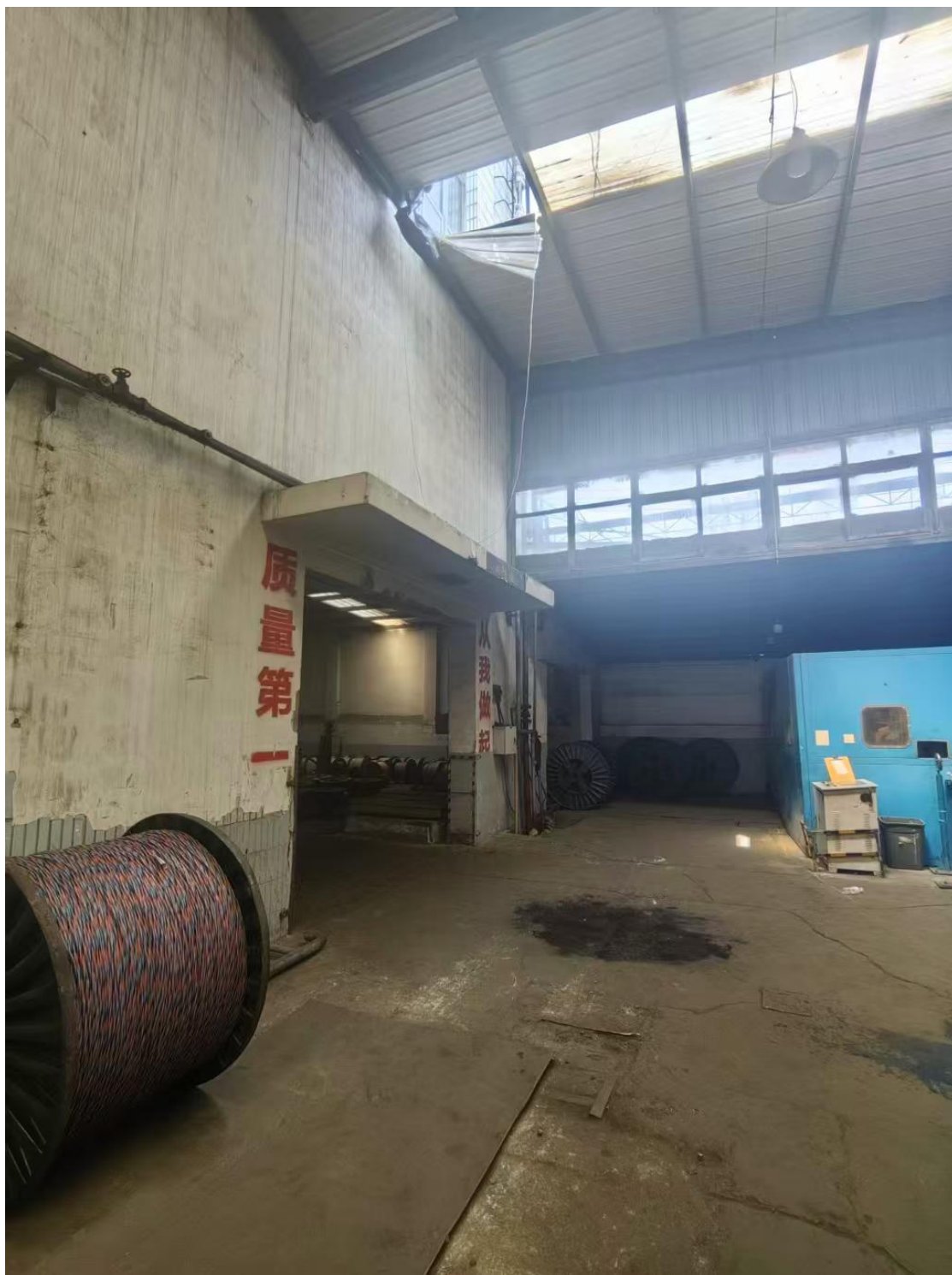
图一 事故现场全景图 1
