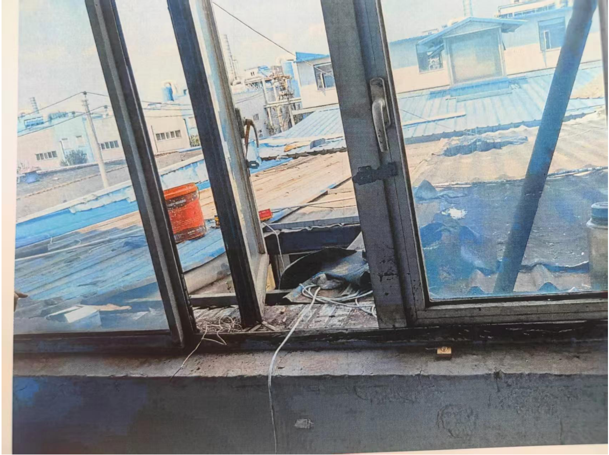
图二 作业人员及死者登上作业面的通道 2
