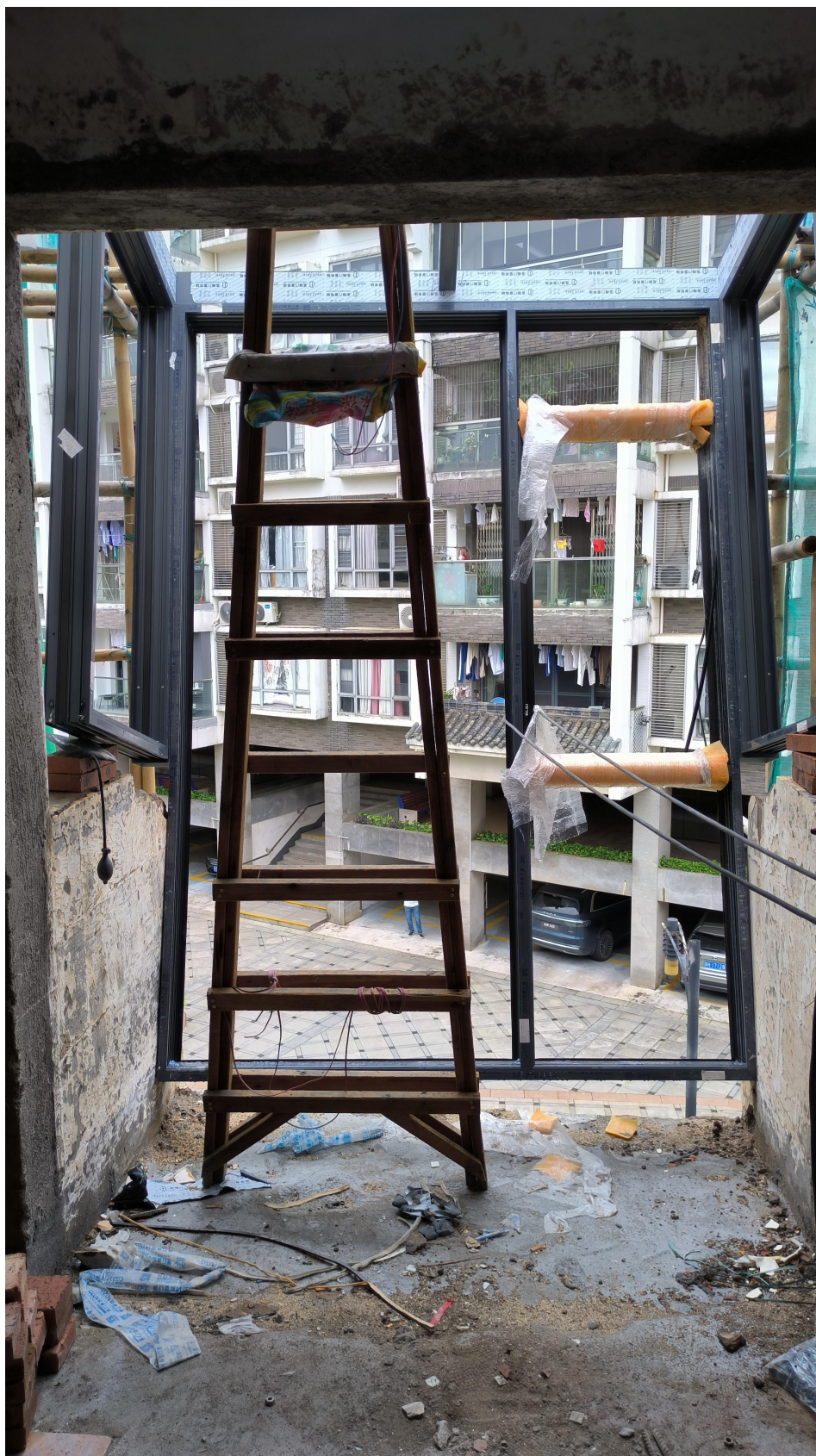
▲ 图 5：事发现场（模拟事发当时自制木质人字梯放置位置）
