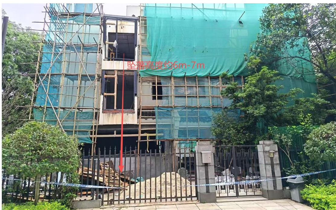
▲ 图 1：事发现场（星湖湾 A 区第*幢别墅外观正面）
