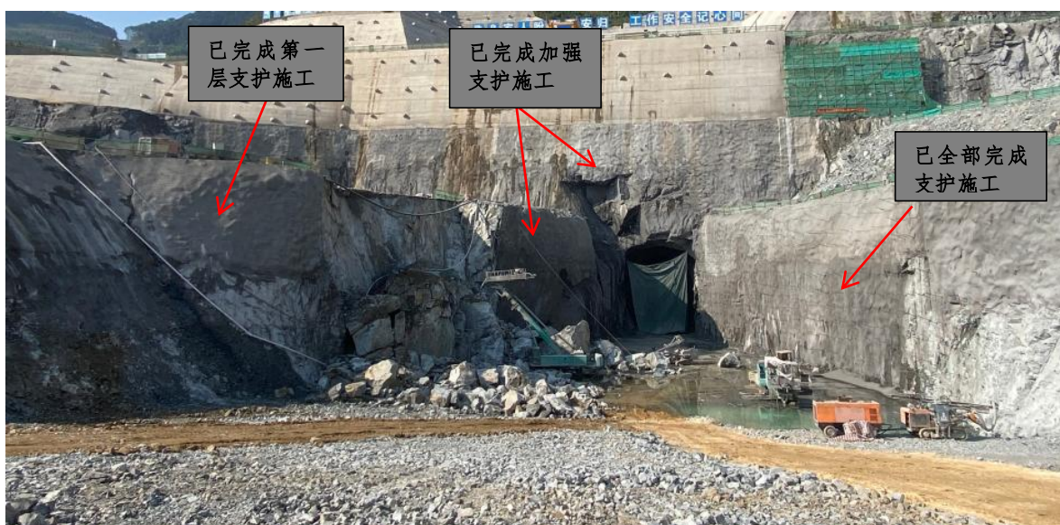
图 6 边坡支护施工情况图
