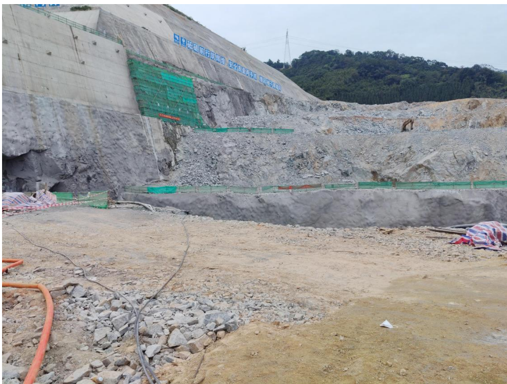
图 12 滑坡上部围挡
