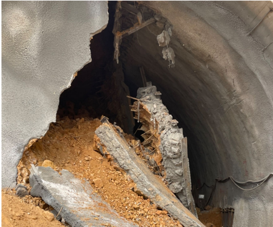
图 11 施工现场（左洞的右导洞）
