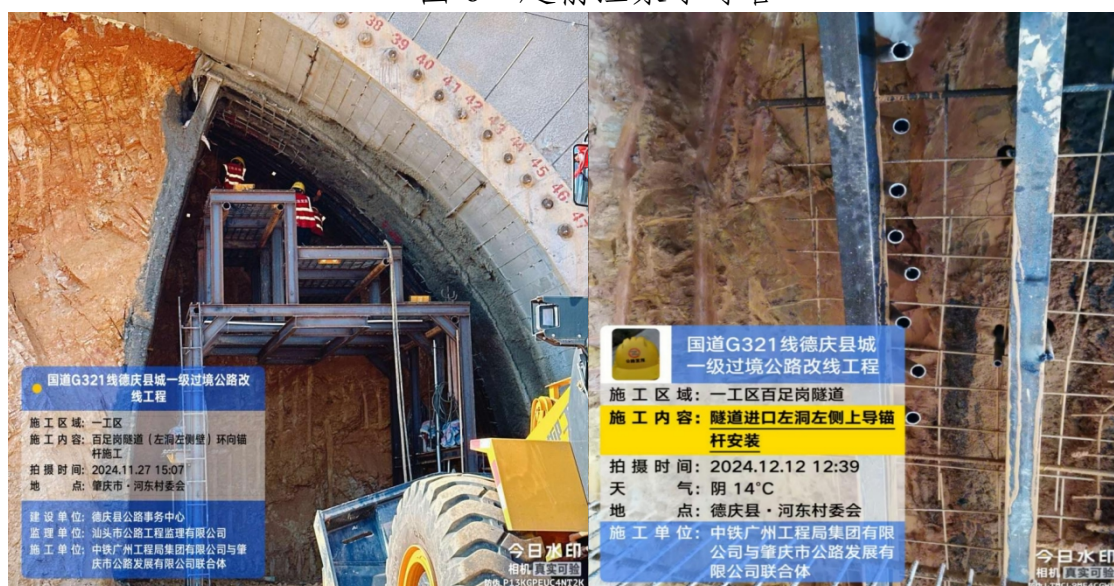
图7 拱顶及核心土锚杆施工
