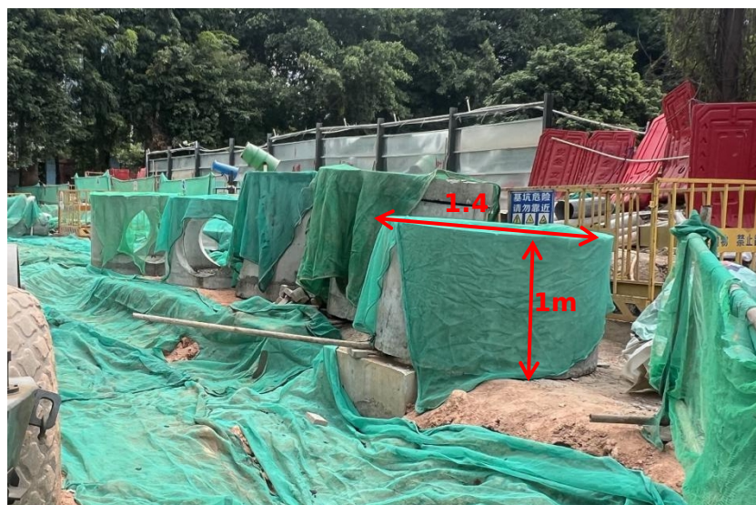
图 2 涉事预制井筒规格尺寸
