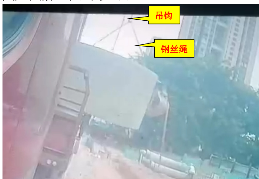
图 11 涉事预制井筒起吊画面
