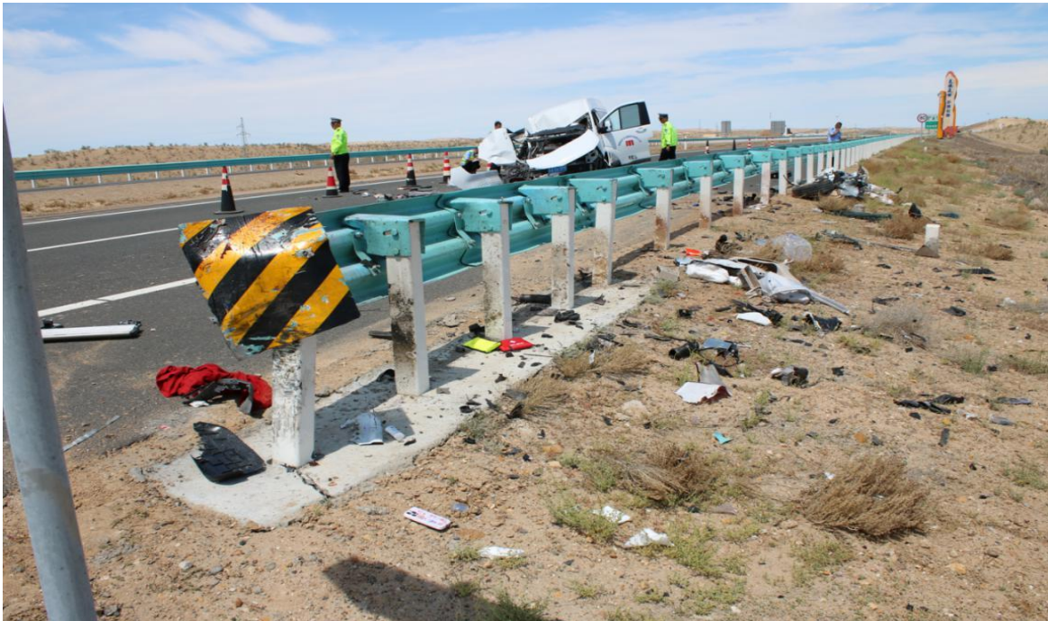
图 1 事故现场照片
