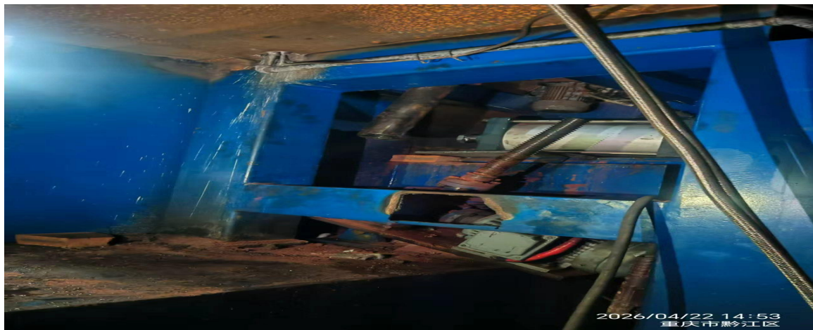
图 2 浇包升降装置脱落后
