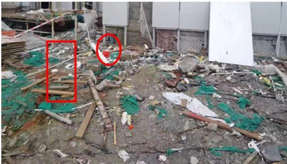
图三、红色方框区域为何**坠落位置、红色圆圈处为何**作业时佩戴的安全帽
