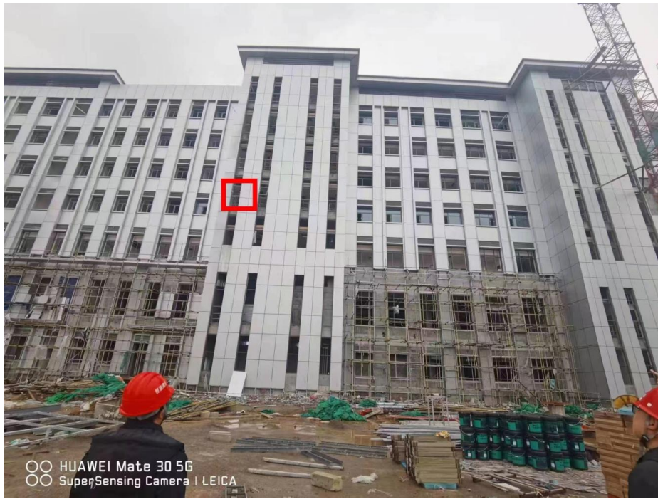
图一、事故发生地外部环境概貌（红色方框区域为何**进行室内窗洞口修补抹灰地点，坠落高度为 14.95 米）
