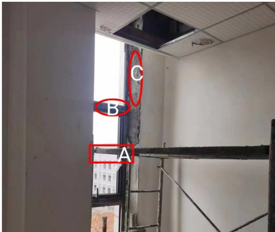
图二、事故发生地内部环境概貌（何**将安全带挂在红色方框 A 区域的窗户横栏上，站在红色圆圈 B 处对红色圆圈 C 处上方区域进行抹灰作业）
