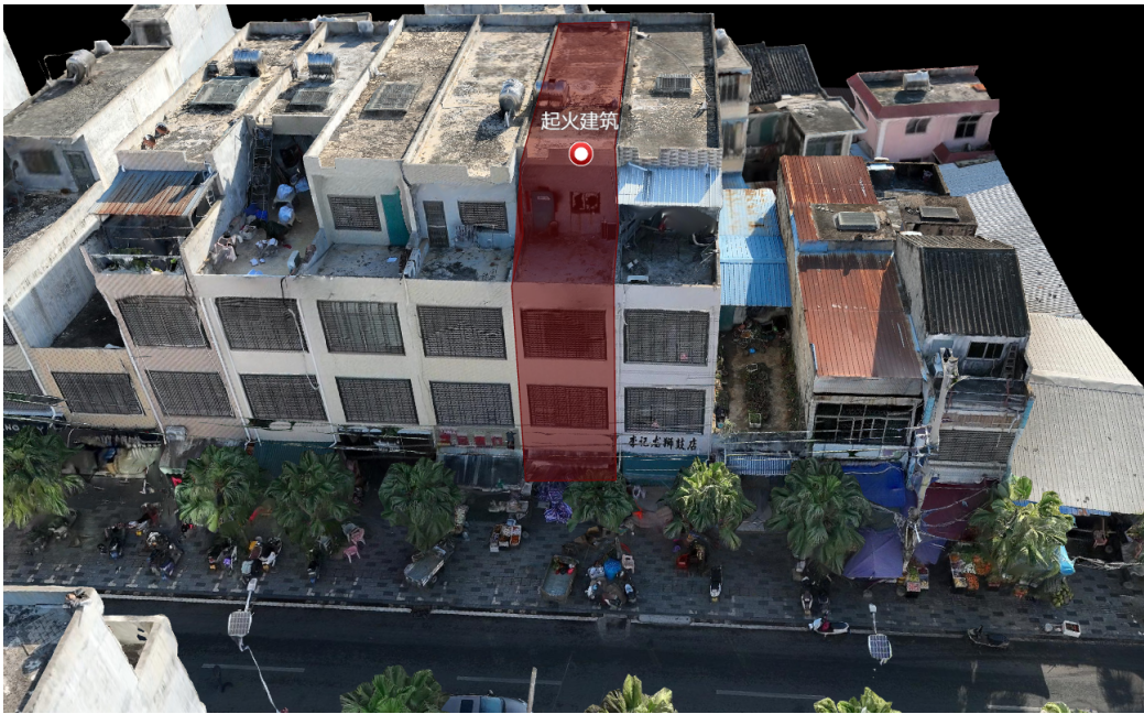
图 1 起火建筑情况
